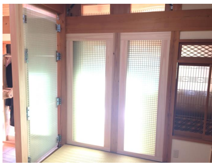
同家の光を通す耐力壁によるリフォーム
