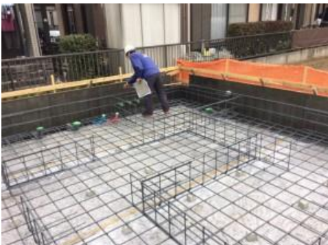
基礎工事 配筋検査合格のご報告
