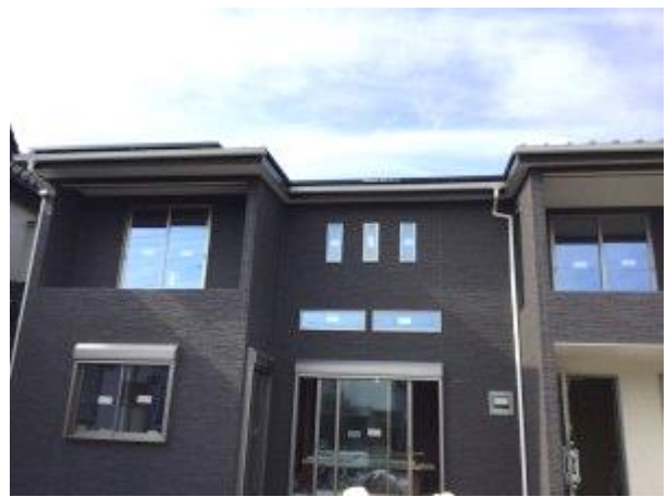
足場取り外し時の外観のご報告
