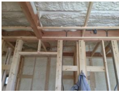
吹き付けウレタン断熱のご報告
