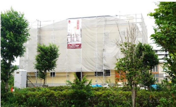
建設中の「プリマ アクエリアス」
